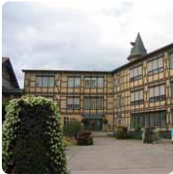
Ehemaliges Nadelwerk und Sitz der Gemeindeverwaltung
